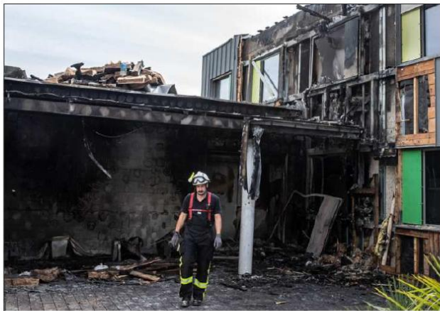
Les flammes se sont propagées à l'étage.
